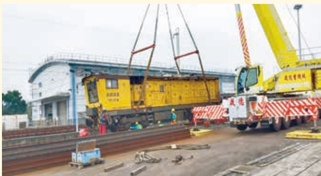
磨軌車吊掛作業
